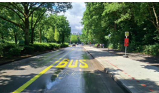
In kürzester Zeit entsteht eine neue Busspur an der Sedentaler Straße in Hochdahl.
